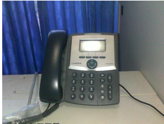
Gambar Pemasangan IP Phone di ruang ICT Dinas Pendidikan dan Kebudayaan Kota Pangkalpinang
