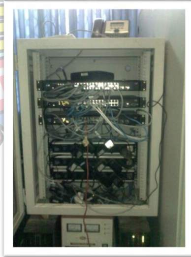
Gambar Pemasangan switch yang menghubungkan server dengan client di ruang ICT Dinas Pendidikan dan Kebudayaan Kota Pangkalpinang
