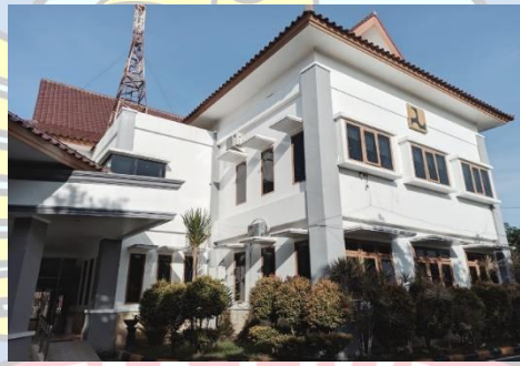
Gambar 3. 1 Kantor Dinas Pekerjaan Umum Penataan Ruang dan Perumahan Rakyat Kawasan Permukiman Perumahan Rakyat
