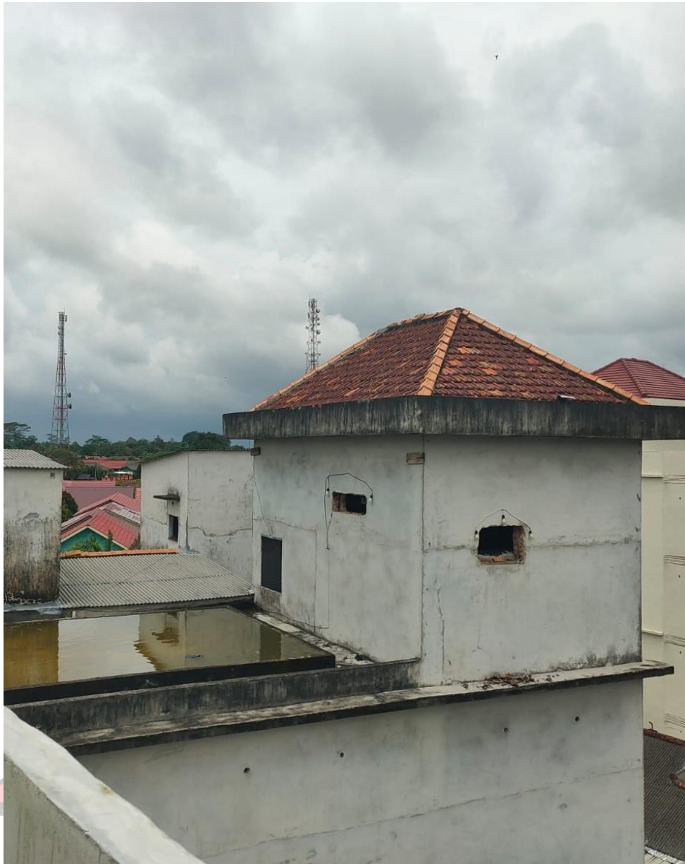
Lampiran 1. 3 Bangunan Tampak Belakang di atas gedung
